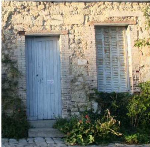
Encadrements récents de briques et linteau métallique taille.
