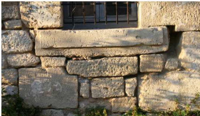
Pierre d'appui retaillée accueillant l'enduit placé sur la et maçonnerie de moellons.
