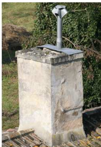
Souche de cheminée en pierre couronnement en briques
