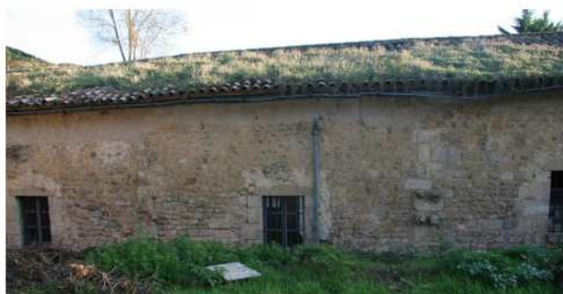
Etat des couvertures îlot B versant nord
