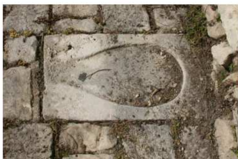
Dalle de pierre de récupération des eaux de pluie
