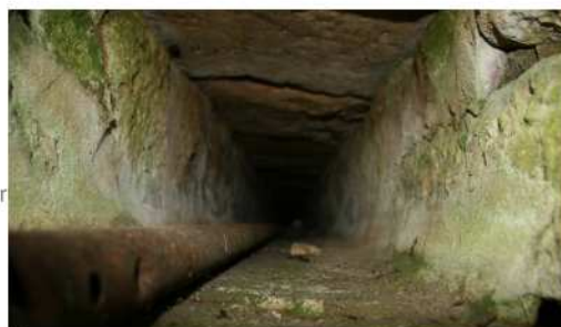
Canalisation traversant le bâti (A10-A11)
