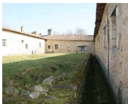
Illustration du mur de soutènement des terres laissant libre le revers pavés de récupération des eaux de pluie. Coupe schématique de l'état des lieux.
