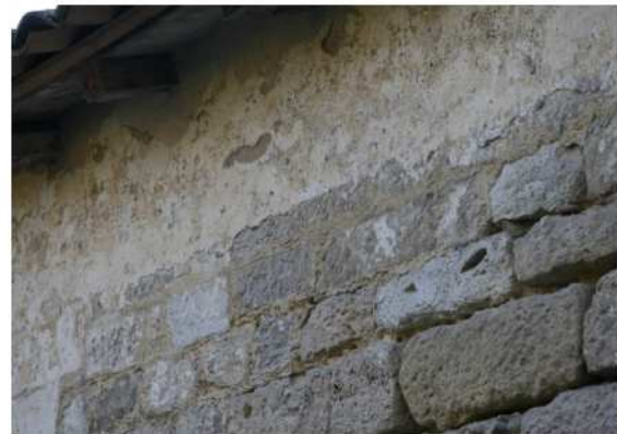
Reste de badigeon à la chaux, sur moellons équarris réguliers.
